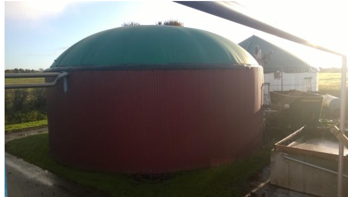
3. Reaktori ja jälkikaasutussäiliö
